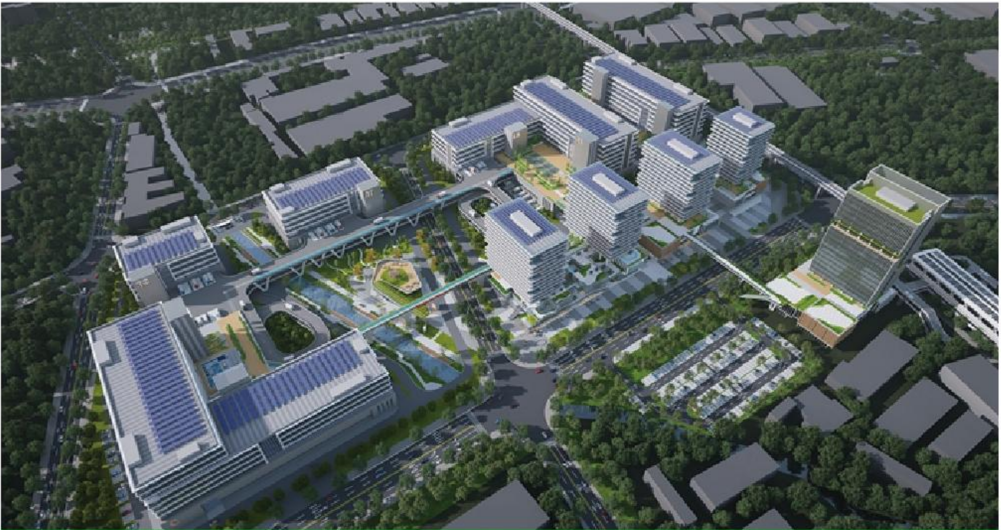
国家级芜湖经济技术开发区汽车电子产业园基础设施建设项目
