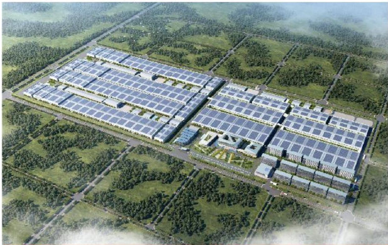
建工三建承建的衢州极电84万套动力电池包、三合一电驱、储能项目及240Wh动力电池项目荣获“中国钢结构金奖”
