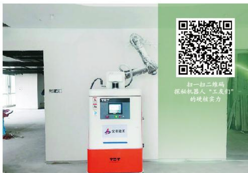
混凝土抹光和室内喷涂智能设备正在作业
