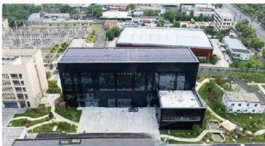
国网安徽蚌埠供电公司变电运检用房项目获得超低能耗标识
