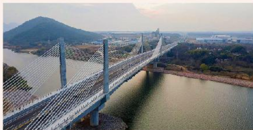
青弋江大道九标段（宣水公路-南漪湖大道）EPC项目以安全环保为主基调，以夯实工程质量、加快产值进度、研发创新技术、规范标准化施工为主要管控手段，确保工程项目精益求精。
